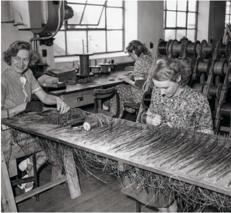
Centralafdelingen 1950, kabelform for PABX 7025 under fremstilling, bagved fremstilling af 4-tråds net.
